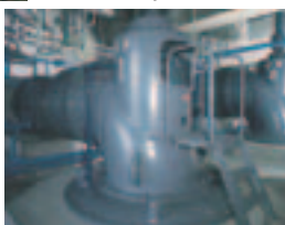
▲大型ポンプを3台設置。
